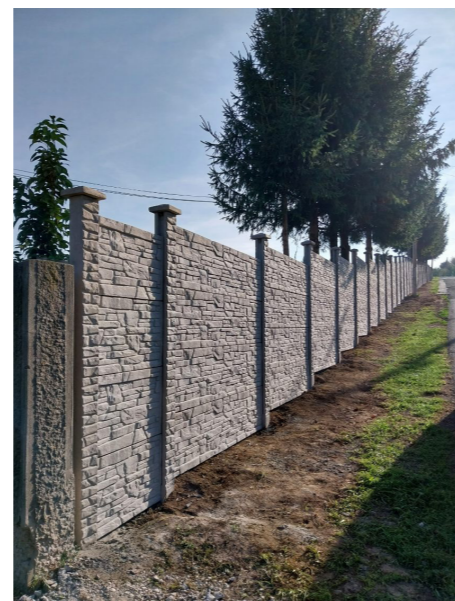
Zrekonštruovaný plot cintorína
