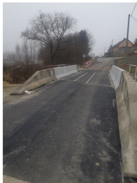
Rekonštrukcia mosta na Záhradné
